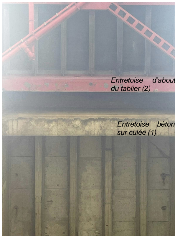
Photographie de la sous-face de l'ouvrage au niveau de la culée RG
