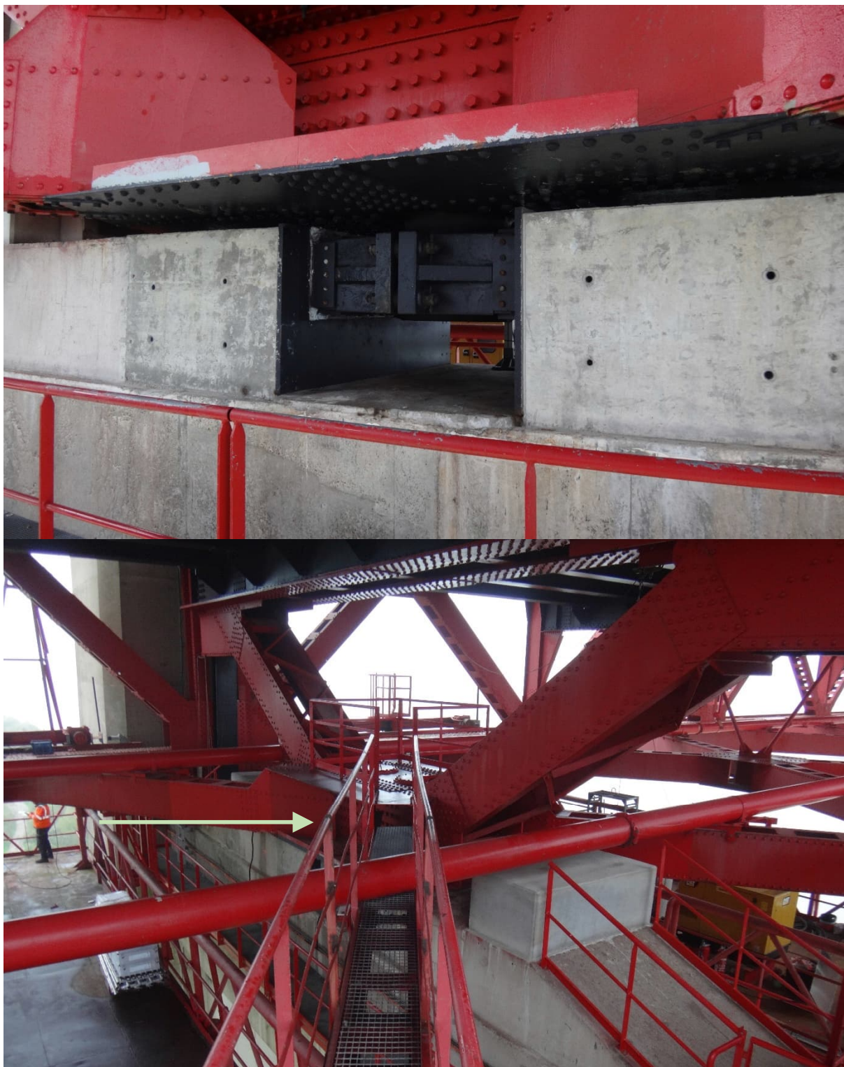
Photographie de la butée au vent de l'ouvrage sur pylône
